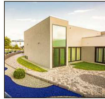
Der Neubau in Helmstedt Foto: Sebastian Petersen / oh
